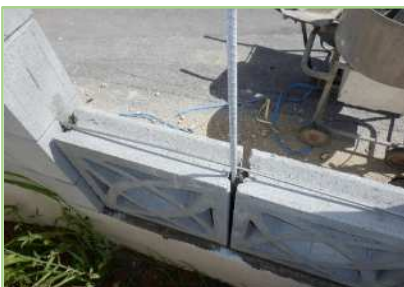
施工例（鉄筋背筋）
